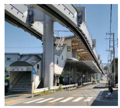
⑦深沢駅支柱&歩道
